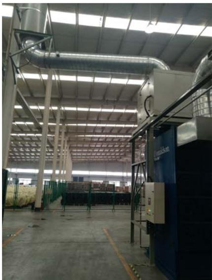
Y机缸体铣床排气筒及净化设施
